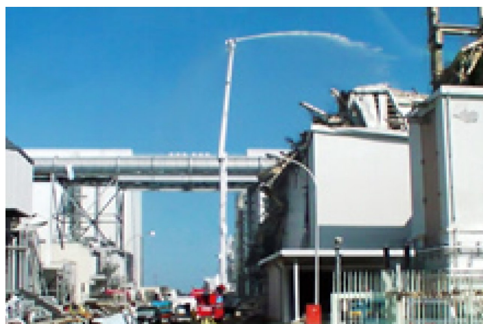
緊急消防援助隊による3号機への放水 (東京消防庁HPより)
